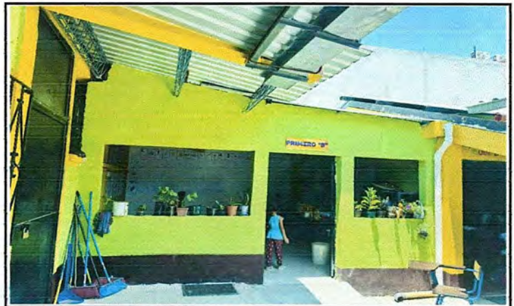
Foto 4: Mejoramiento techo tipo portico
