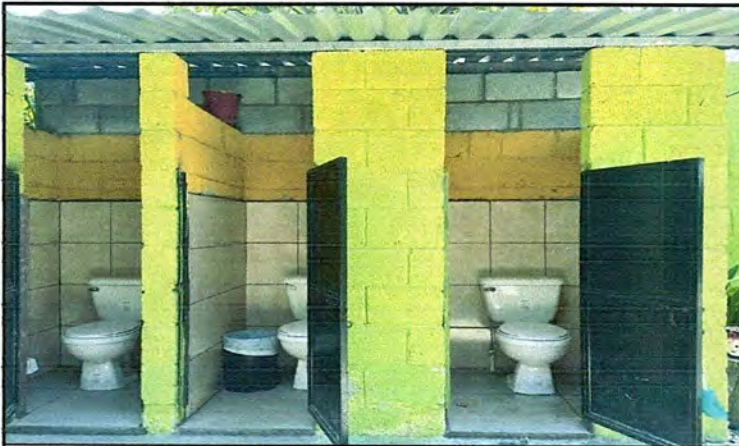
Foto 3: Mejoramiento de baños, piso, techo, azulejo
