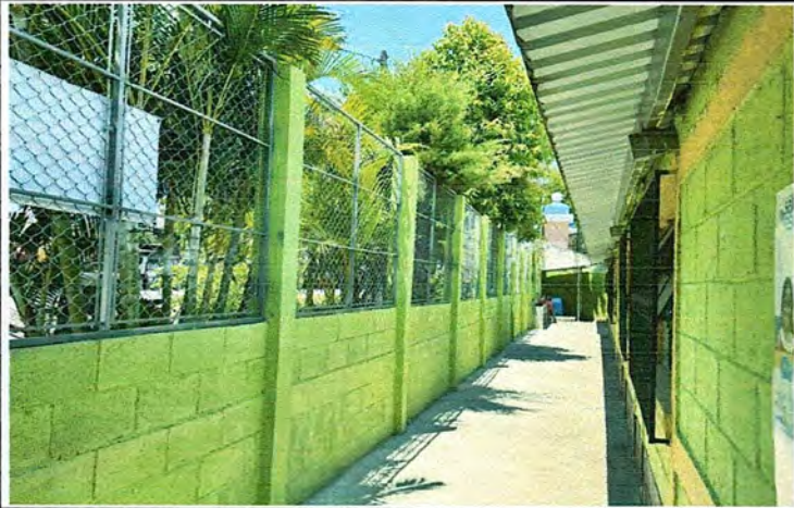
Foto 1: Mejoramiento de Muro perimetral
