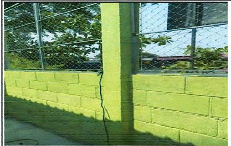
Foto 2: Mejoramiento Muro perimetral
